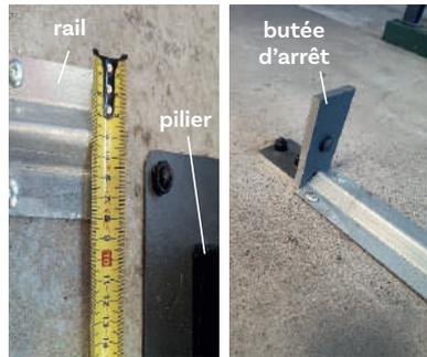
3.4. Fixez le rail à 2 cm derrière le pilier puis fixer la butée d'arrêt.
